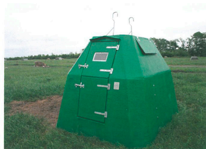
Poca hytten er fremstillet i glasfiber og monteret med to døre. Den ekstra dør er to-delt. Foto: Heidi M. Andersen
